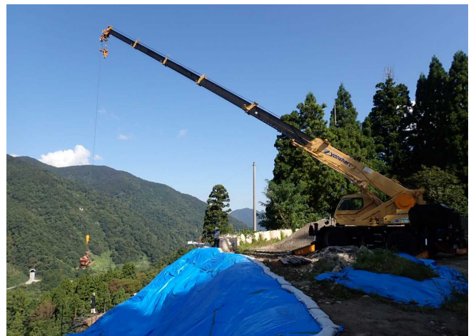
【資機材搬入・搬出状況写真】
