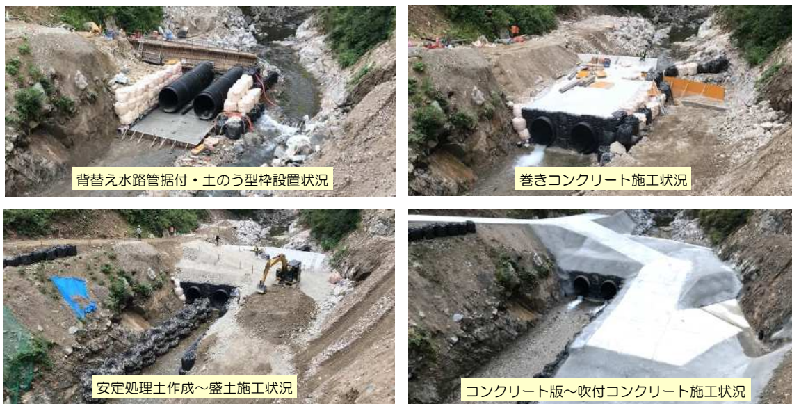
写真-7 吐口部造成ヤード整備工施工状況写真
