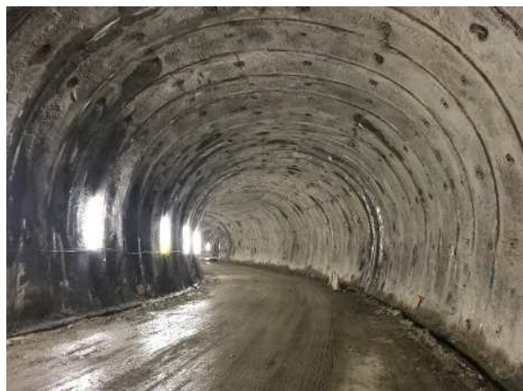
写真-3 トンネル坑内【舗装工着手前】
