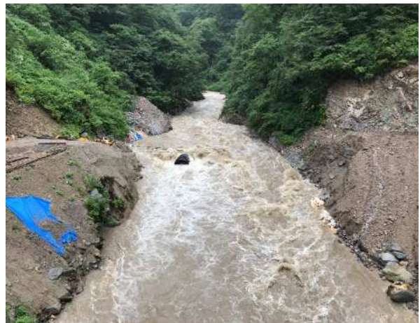
写真-6 河川増水に伴う被災状況(8月14日)
