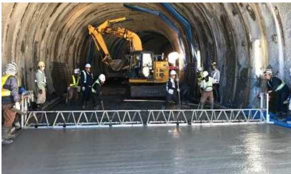
写真-7 全断面簡易フィニッシャーによるコンクリート打設状況
