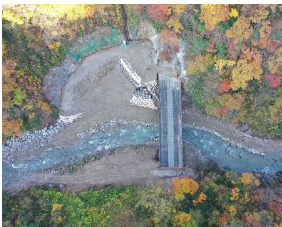
写真-1 吐口部造成ヤード【着手前】
