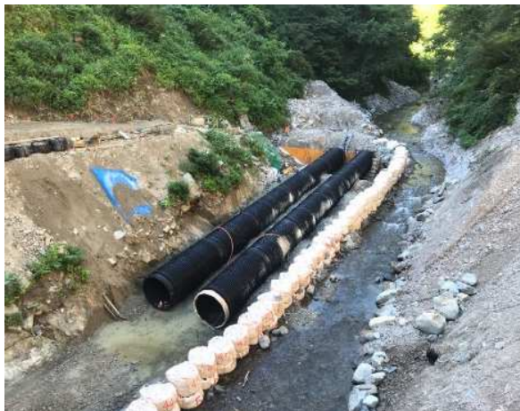
写真-5 背替え水路管設置状況
