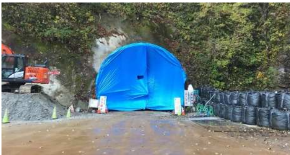
写真-8 トンネル坑口部ブルーシート・ジェットヒーターによる養生状況
