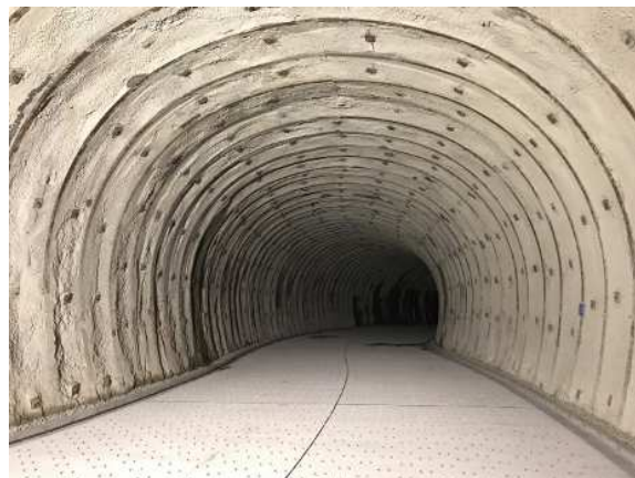
写真-4 トンネル坑内【完成】
