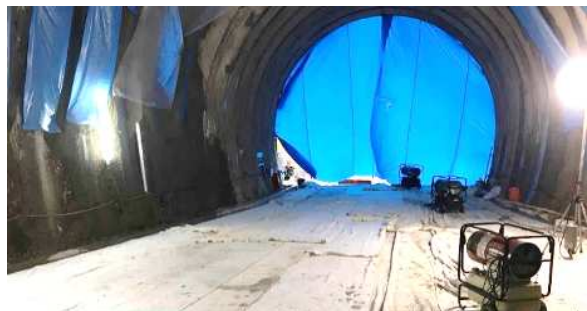
写真-8 トンネル坑口部ブルーシート・ジェットヒーターによる養生状況
