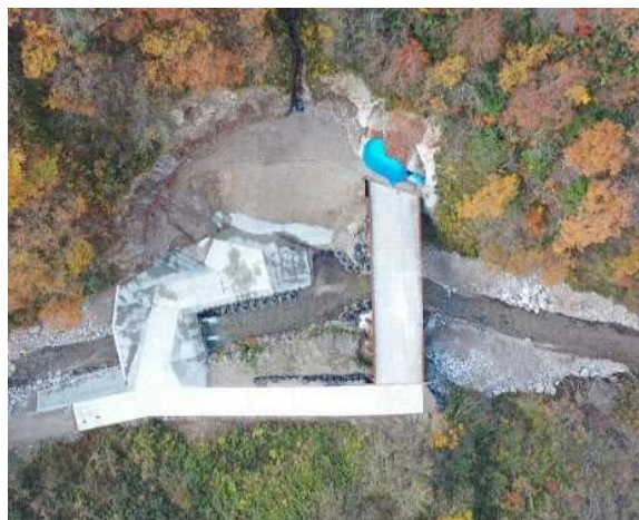
写真-2 吐口部造成ヤード【完成】
