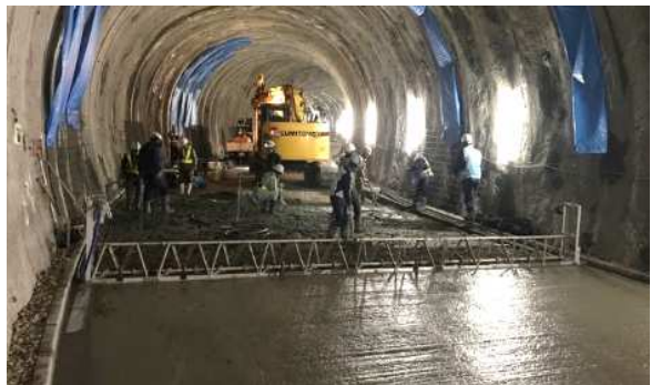
写真-7 全断面簡易フィニッシャーによるコンクリート打設状況
