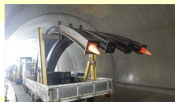
写真 20 鋼製支保工端部明示
