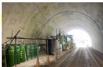
写真5 設備の坑内設置
