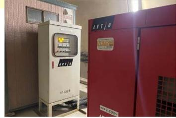
写真8 自動電源供給設備
