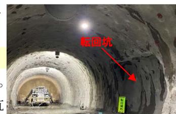
写真3 転回坑構築
