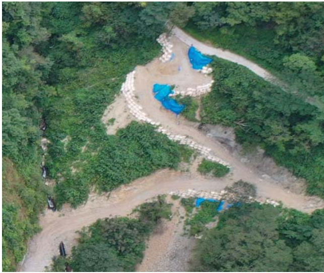
起点部工事用道路完成
