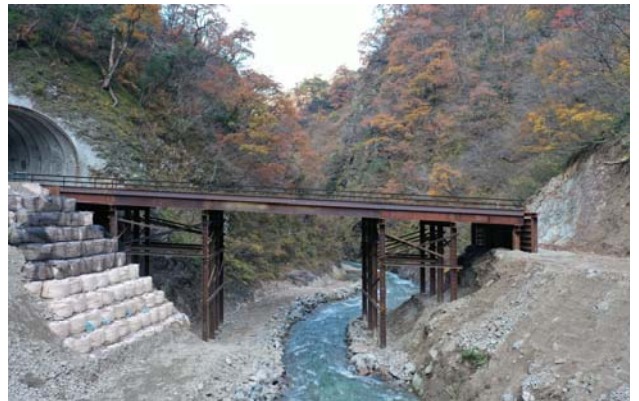
【草嶺工区仮栈橋完成】
