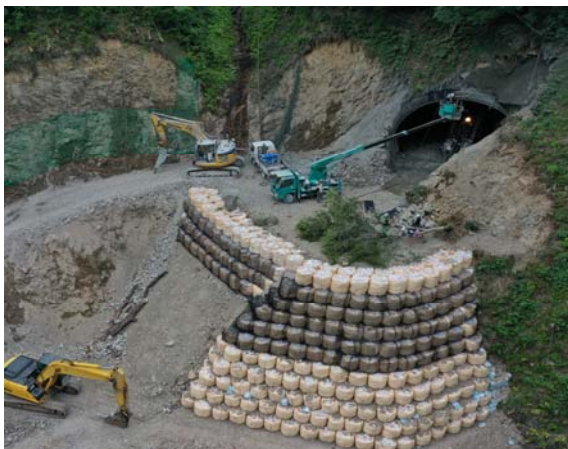
作業ヤードを利用した抗口覆工作業状況
