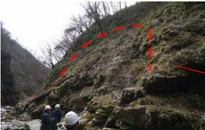
崩壊跡地形で局所的に崩積土砂が滞留
