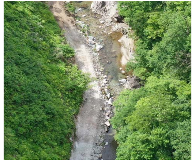
河川内工事用道路完成
