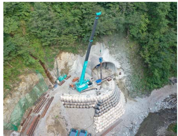
作業ヤードを利用した仮栈橋の施工状況
