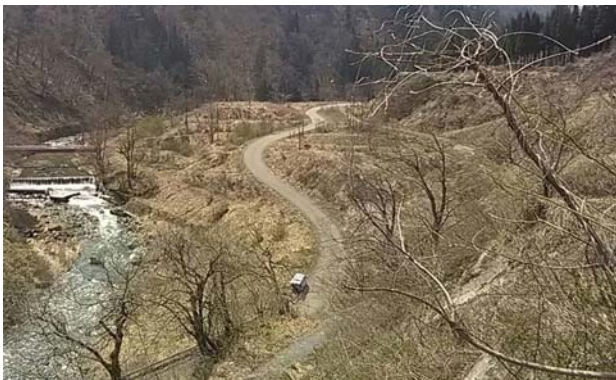
【岩淵工区仮栈橋着工前】
