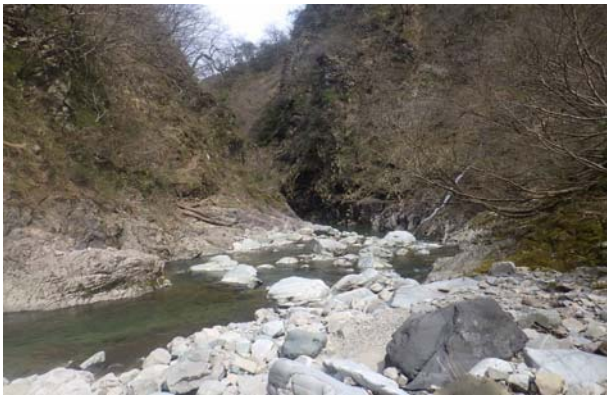
【草嶺工区仮栈橋着工前】
