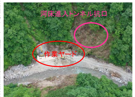
河床進入トンネル抗口写真
