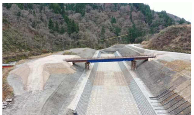
【岩淵工区仮栈橋完成】
