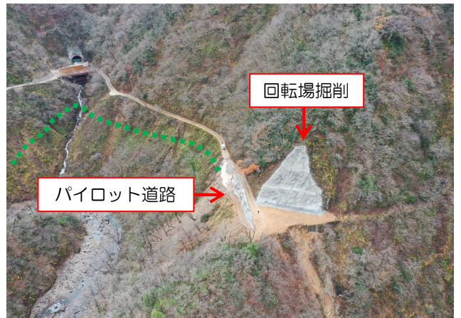
【パイロット道路完成】
