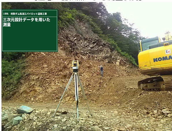
【任意の器械点による測量状況】
