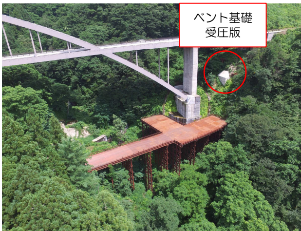
【豆谷工区着工前】
