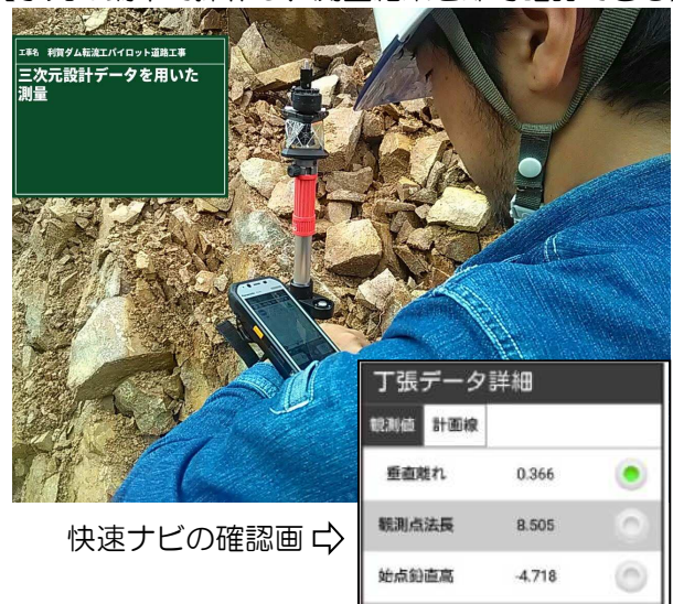
【手元の端末で操作し、測量結果を即時確認できる】
