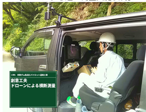
【UAVによる起工測量実施状況】
