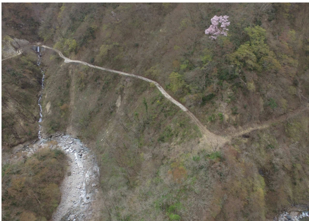
【パイロット道路着工前】
