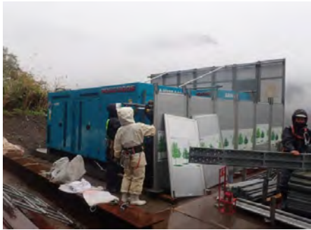
【写真6-吸音パネル組立】
