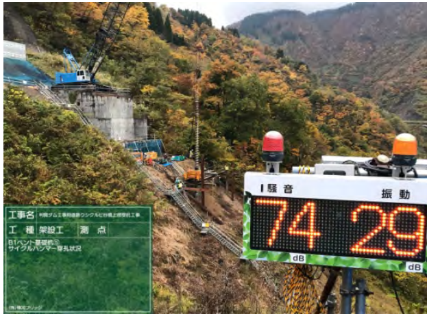
【写真4-B1施工時の振動・騒音測定】
