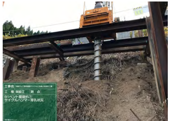
【写真2-掘削状況】
