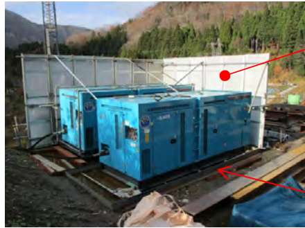
【写真7-吸音パネル設置状況】
