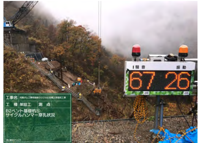
【写真5-B2施工時の振動・騒音測定】
