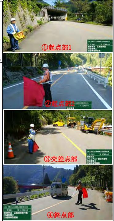
③狭い施工ヤードにおいて、工事の内容と資機材の配置に合わせて計画的に誘導員を配置した。
