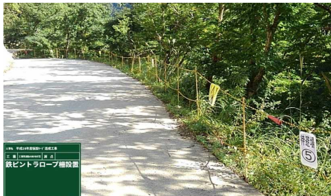
【写真①】鉄ピントラロープ柵設置
