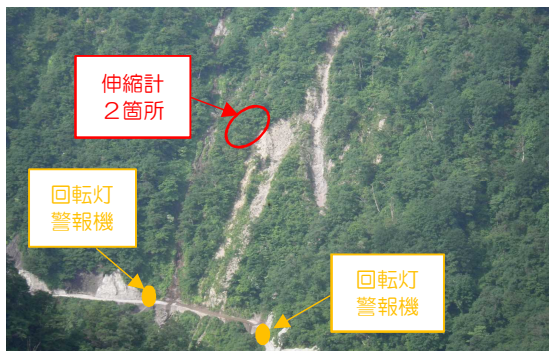
【写真③】伸縮計、回転灯、警報機設置位置
