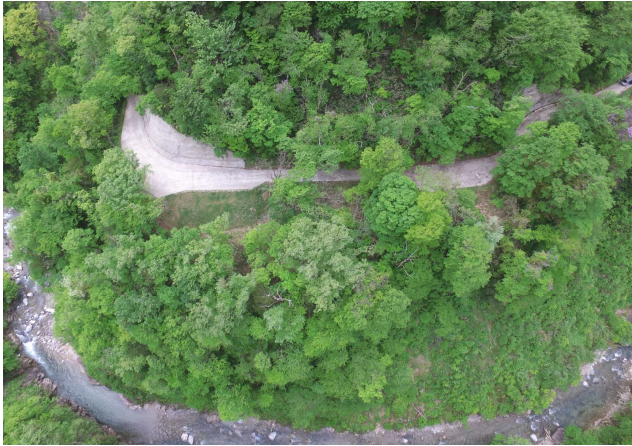
【ヤード造成着工前】
