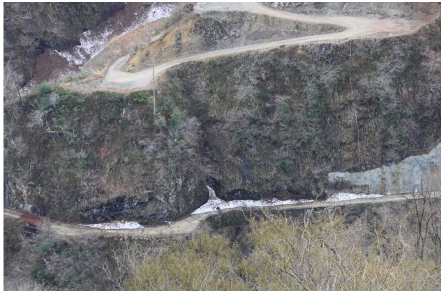
【道路拡幅（対策工1）着工前】
