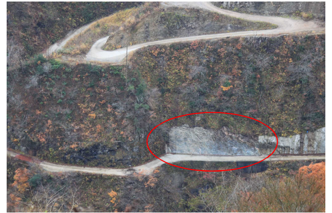
【道路拡幅（対策工1）完成】
