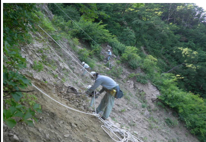
【写真①】浮石除去状況
