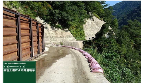
【写真②】赤色土のう設置
