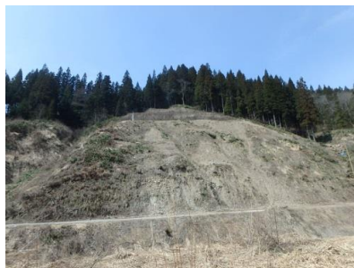
施工前の全景写真 (堆積層表面)
