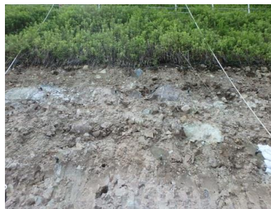
法面整形後の地山表面
