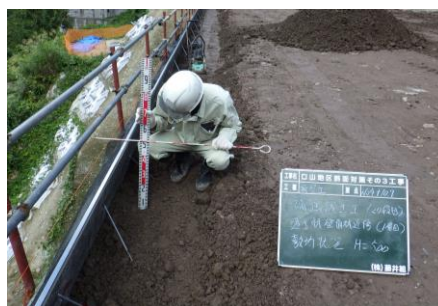
【1層100mmの敷均し状況】
