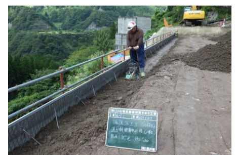
【小型転圧機による転圧状況】
