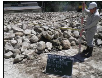
【破碎岩敷均し厚さ0.8m】
