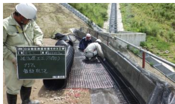
【水平排水材敷設完了】
