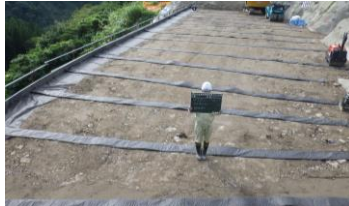
【水平排水材敷設完了】
