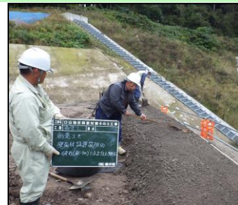
【RC-40敷均し状況】
