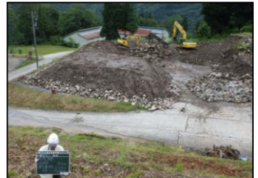
【選別土敷均し】
