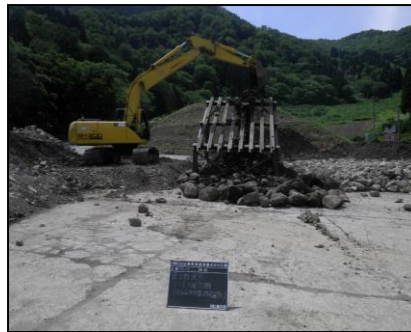
【岩塊除去状況】
