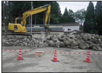
【岩塊小割り状況】
