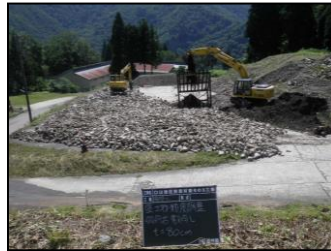
【破碎岩敷均し状況】
