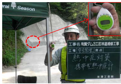
【写真-16 携帯型熱中症計現場常備】
