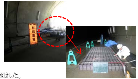
【写真-2 資機材置場(トンネル内)】
