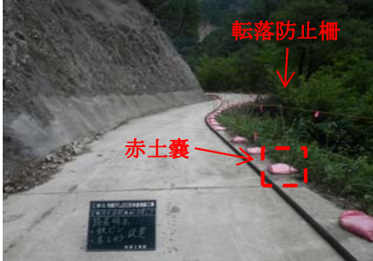
【写真-6 転落防止柵・赤土嚢明示】
