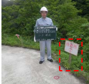
【写真-7 待避所看板設置】
