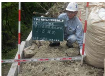
【写真-4 小段幅(1m以上)確認】
