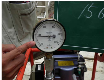
目視による油圧ゲージの確認
