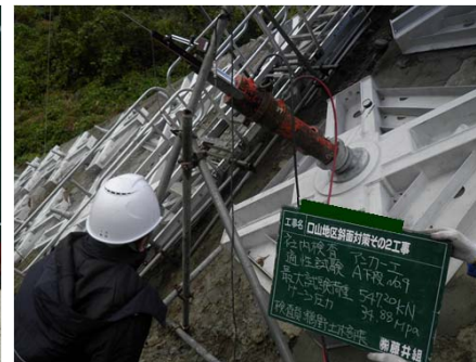
アンカー変位量の確認
