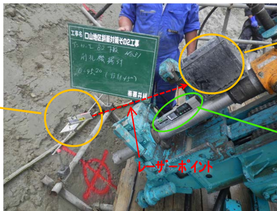
レーザー分度器による削孔角度管理
