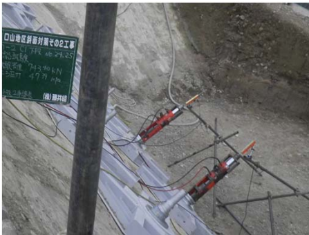
遠隔操作による緊張作業(2台同時)
