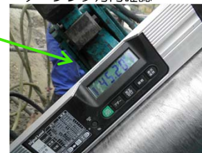
上下方向の削孔角度管理
