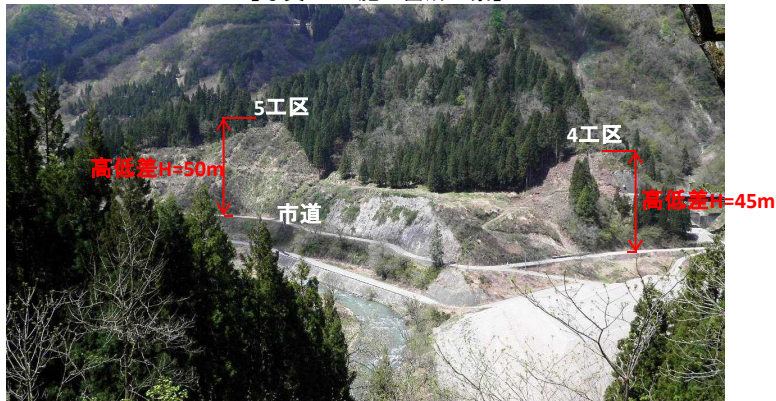
【写真-1 施工箇所全景】
