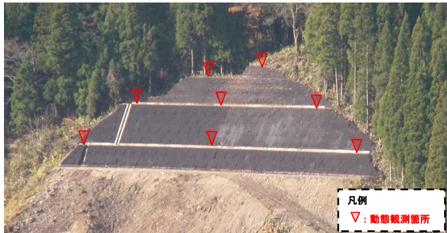
【写真-6 5工区施工箇所全景】
