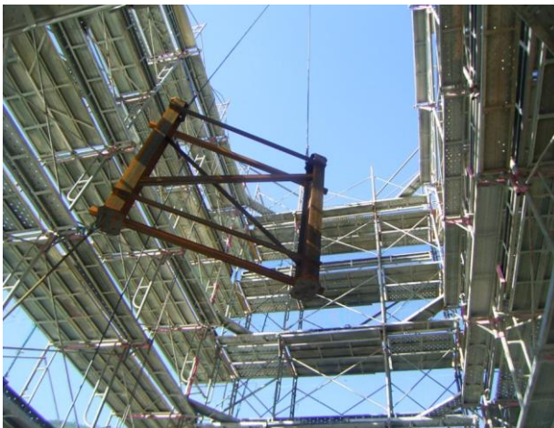
架台吊り込み状況
