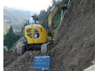
【写真-3 3段目法面:狭小部掘削状況】
