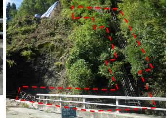
【写真-8 昇降階段設置完了】
