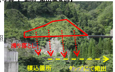
【写真-2 4段目法面:人力掘削状況】
