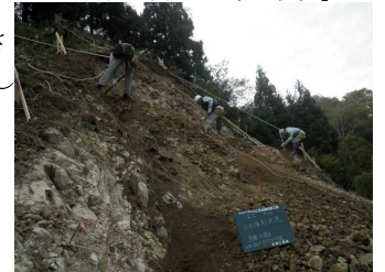
【写真-2 4段目法面:人力掘削状況】
