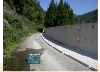
【写真-6 プレキャストL型擁壁設置完了】
