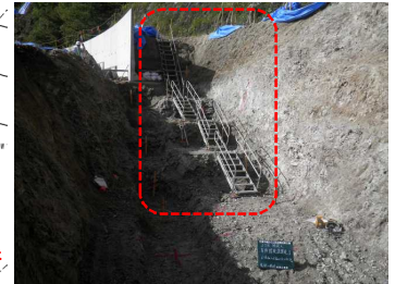
【写真-7 作業通路(昇降階段)】
