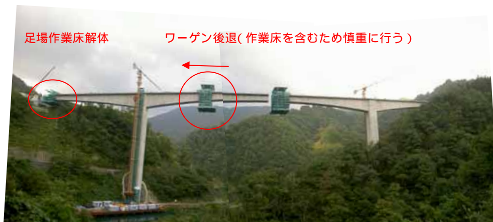
写真-7 ワーゲン後退解体状況 ( P 1 )
