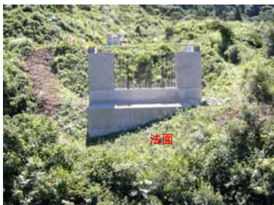
写真-10 A 2 側径間現況地盤
