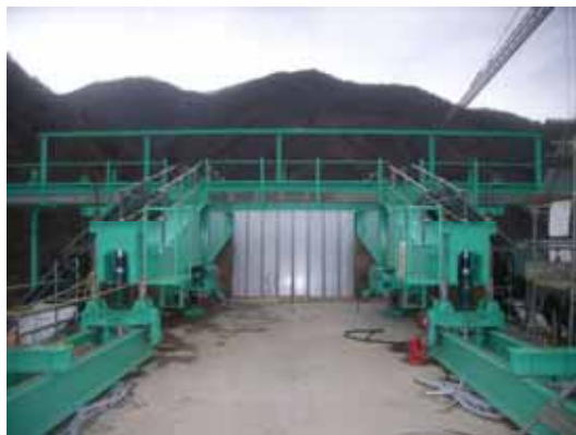
写真-4 越冬前の橋面
