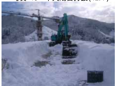
写真-17 橋面除雪(12/12)
