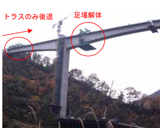
写真-8 ワーゲン足場解体 ( P 2 )
