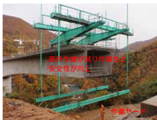
写真-14 A 2 側ワーゲン解体状況
