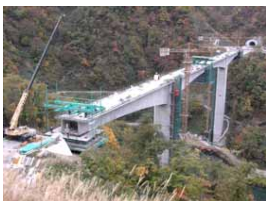
写真-13 A 2 側ワーゲン解体状況
