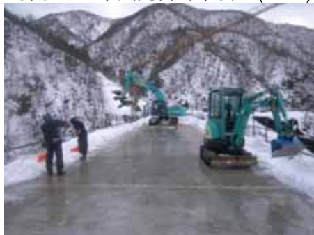
写真-18 橋面除雪(12/14)
