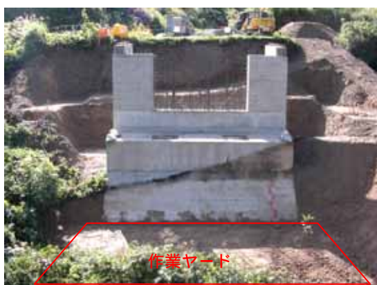
写真-12 A 2 側径間ヤード造成完了
