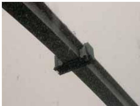
写真-16 中央閉合寒中養生(12/7)
