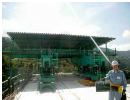
写真-6 ワーゲン屋根設置完了
