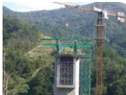
写真-1 主桁断面と固定式クレーン
