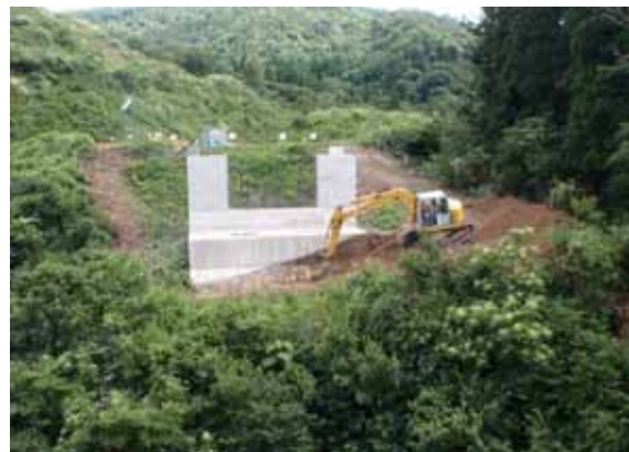
写真-11 A 2 側径間ヤード造成状況
