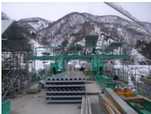
写真-5 ワーゲン屋根設置状況
