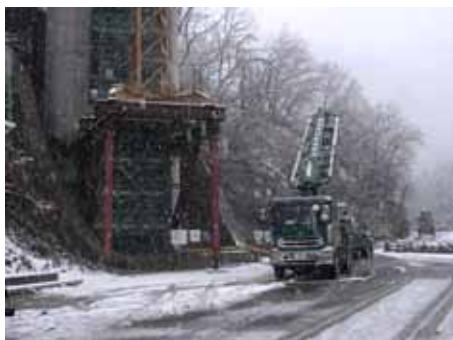
写真-15 中央閉合打設(12/7)
