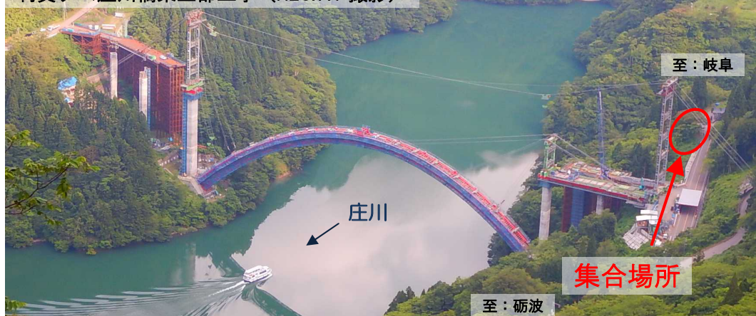
利賀ダム庄川橋梁上部工事 (H28.7.1 撮影)
