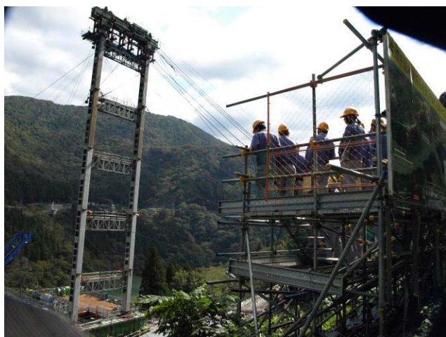
H27.10 見学会の状況 利賀ダム庄川橋梁上部工事
