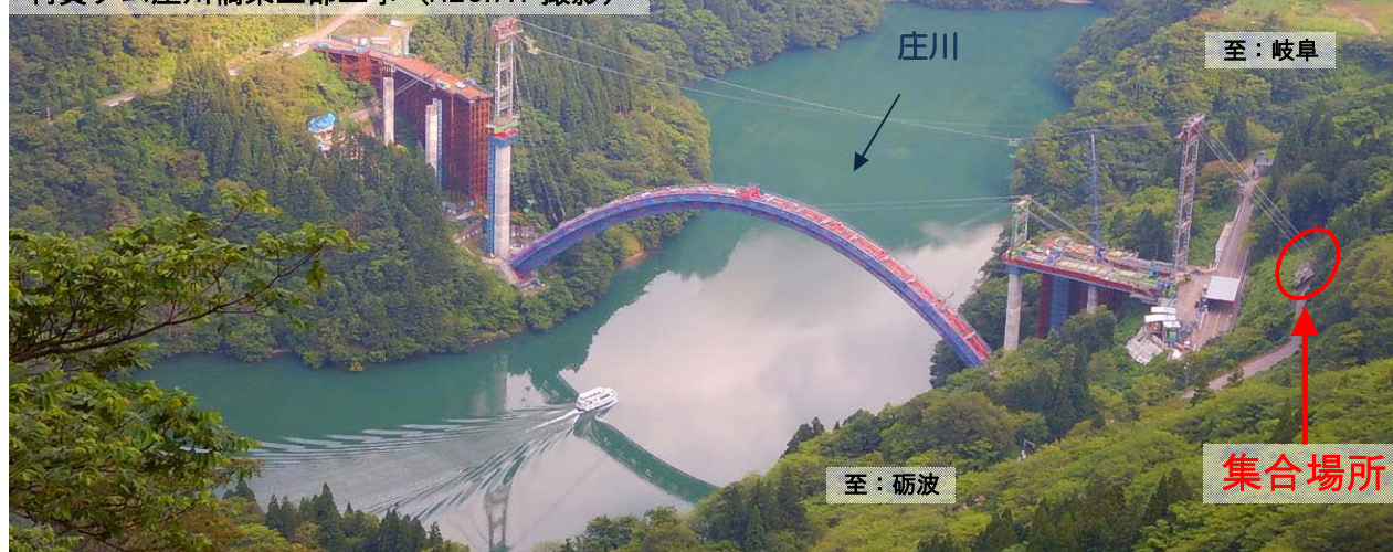
利賀ダム庄川橋梁上部工事 (H28.7.1撮影)
