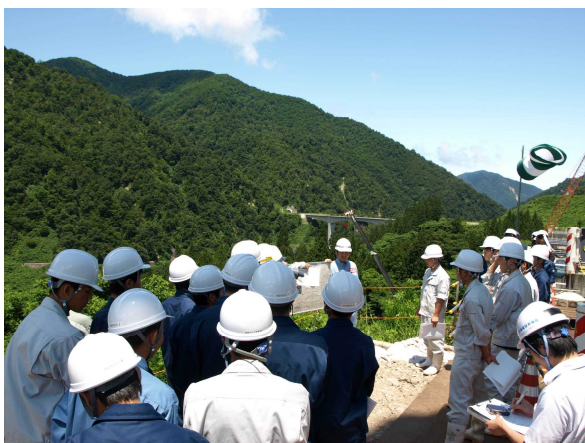
利賀ダム豆谷橋梁上部その2工事
