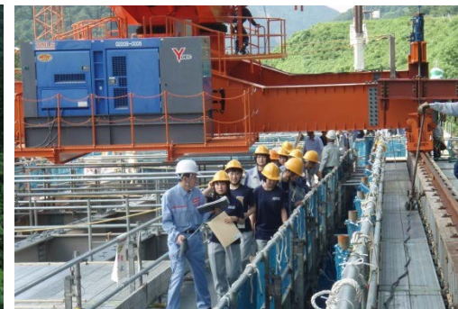
豆谷橋梁の補剛桁上足場にて
