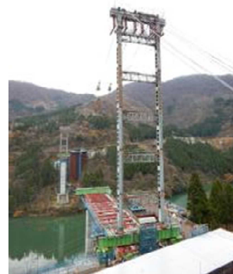
H27.11末時点の 現場状況(庄川橋梁)
