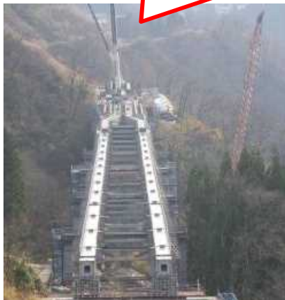
H27.11末時点の 現場状況(豆谷橋梁)
