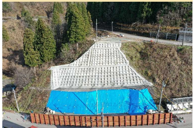
令和4年12月の現地状況
