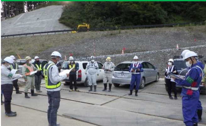
写真⑤: 令和3年度利賀ダム付替市道整備工事の安全対策点検
