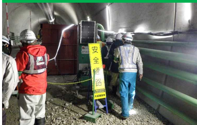
写真④: 利賀トンネル(2工区)工事の安全対策点検
