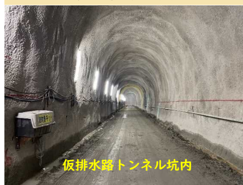
2月下旬の現地状況
