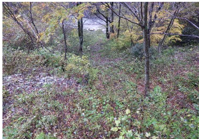
管理用通路 撤去・搬出完了
