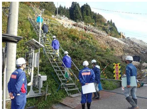
▲ 法面対策工事の現場
