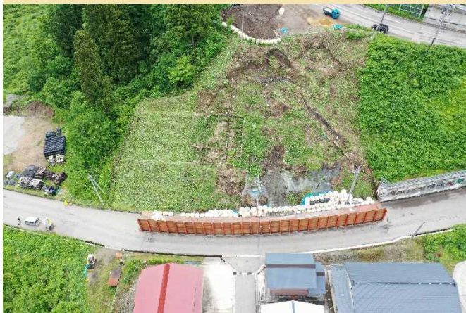
着工前の現地状況
