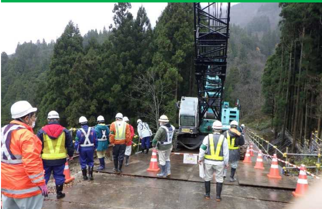
写真①: 令和3年度押場進入路その2工事の安全対策点検
