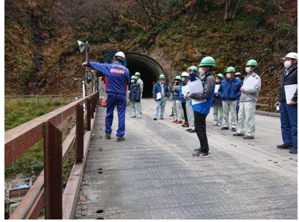
▲ 転流工現場での説明の様子
