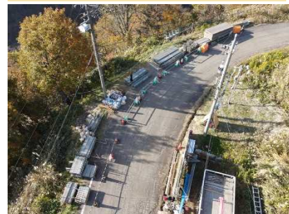
ダムサイト右岸 資材集積状況
