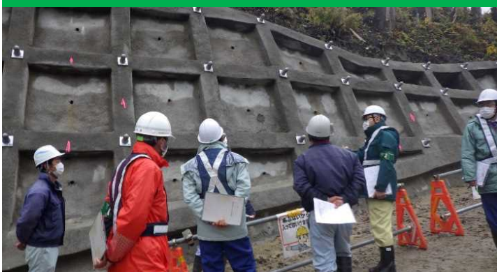
写真④: 令和3年度押場進入路その3工事の安全対策点検
