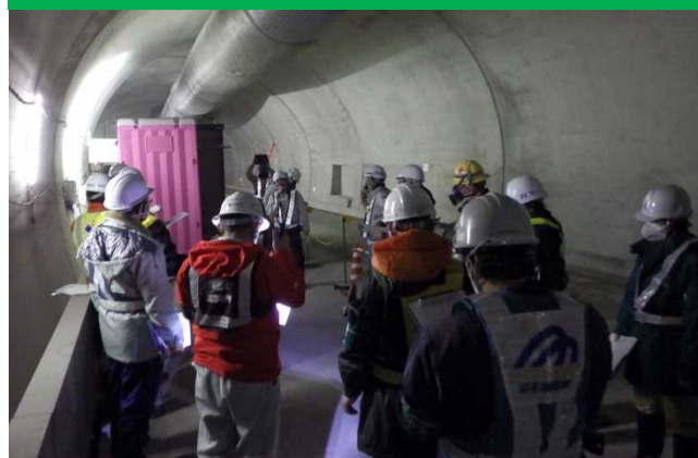
写真⑤: 利賀トンネル(2工区)工事の安全対策点検
