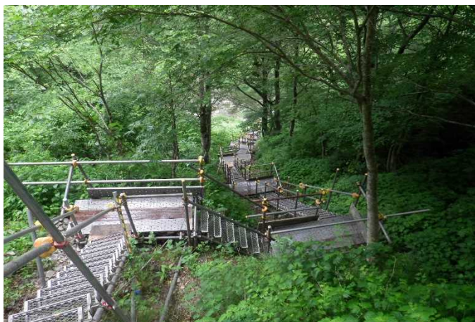
管理用通路 設置完了
