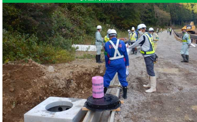
写真⑥: 令和3年度利賀ダム付替市道整備工事の安全対策点検
