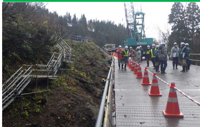
写真③: 令和3年度押場進入路その2工事の安全対策点検
