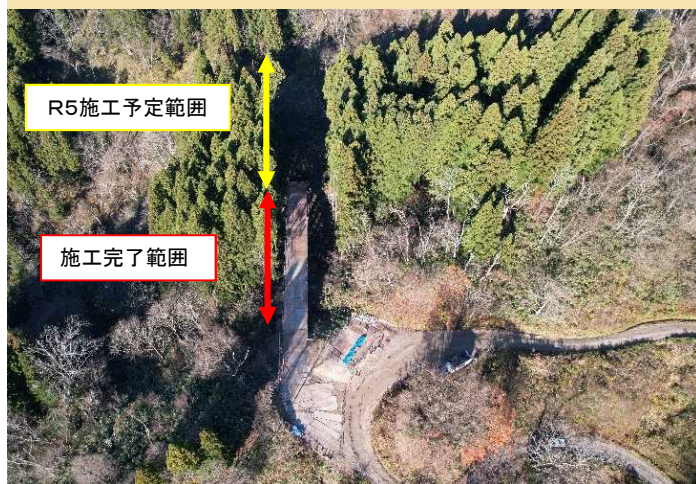
11月下旬の現地状況
