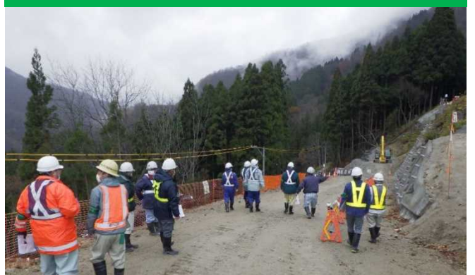
写真⑤: 令和3年度押場進入路その3工事の安全対策点検
