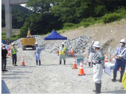
現場作業状況の確認 [(株)藤井組 現場]
