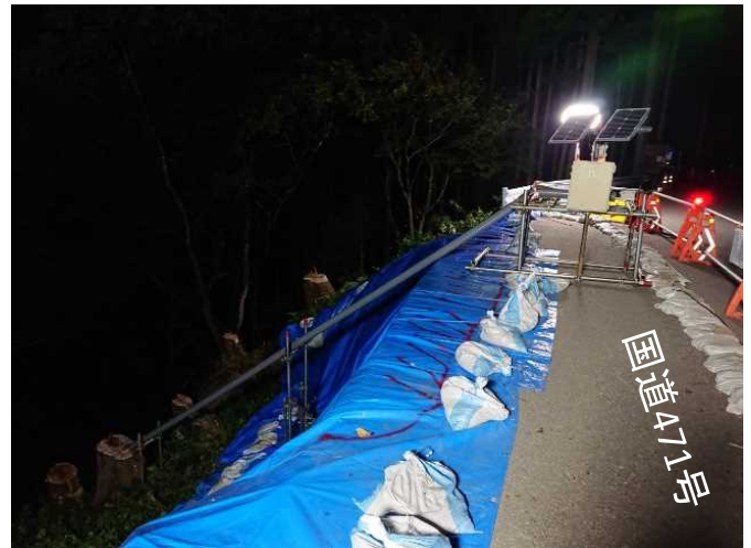
8/31 23:45頃 ブルーシート及び 変状観測機器設置完了状況
