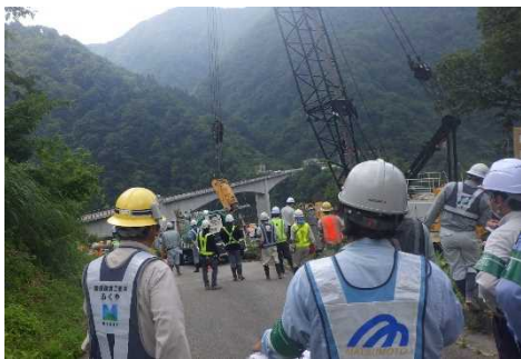
現場作業状況の確認 [松本建設(株) 現場]
