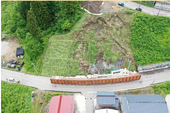
着工前の現地状況
