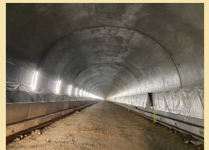
トンネル側溝据付完了全景
