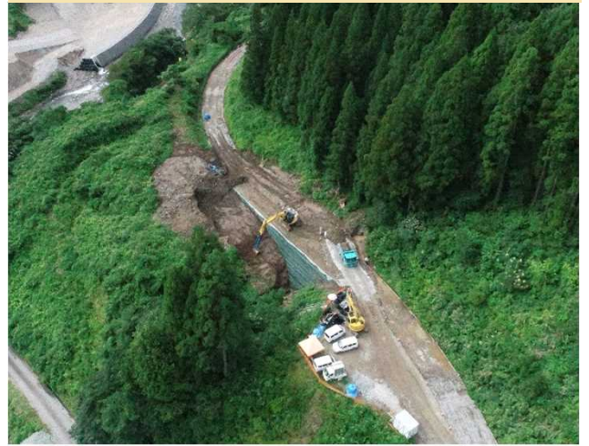
補強盛土施工状況
