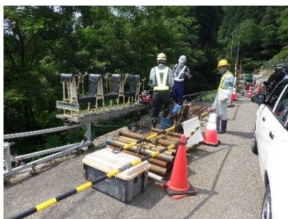
資材保管状況の確認 [(株)村尾地研 現場]
