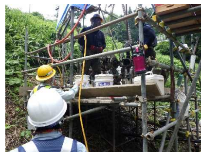
地質調査作業状況の確認 [(株)ホクコク地水 現場]
