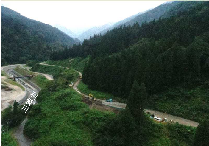
8月下旬の現地状況
