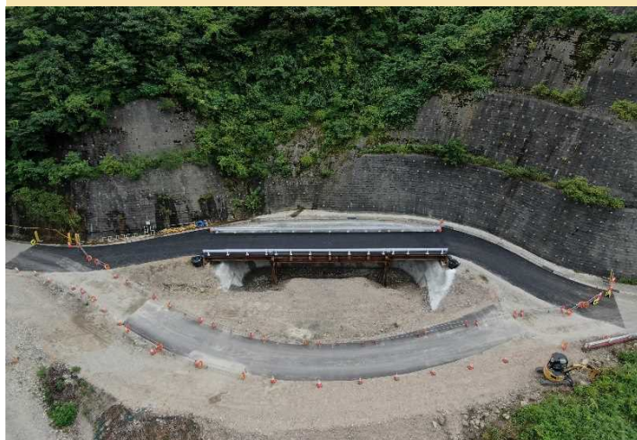
8月下旬の現地状況
