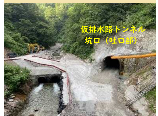
8月下旬の現地状況
