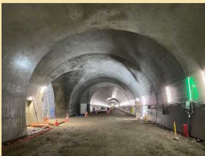
河床進入トンネル分岐部全景
