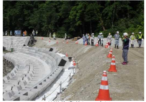
現場作業状況の確認 [竹沢建設(株) 現場]
