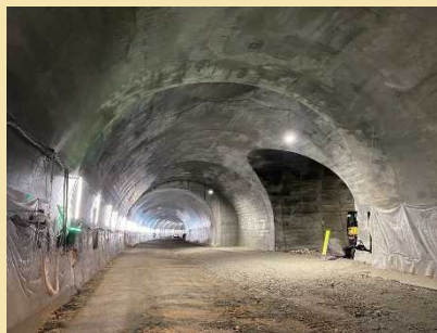
ダム天端連絡トンネル分岐部全景
