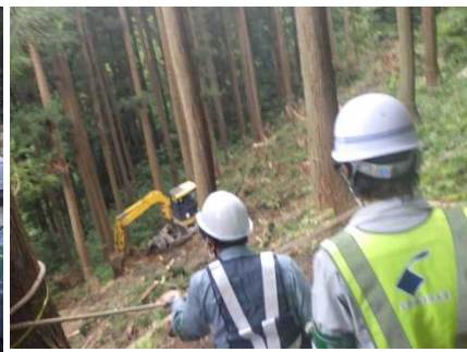
伐採作業状況の確認 [中越興業(株) 現場]
