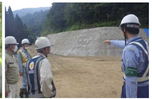
現地作業状況の確認 [(株)岡部 現場]
