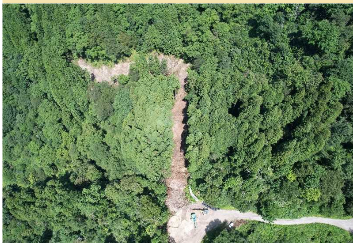
8月下旬の現地状況
