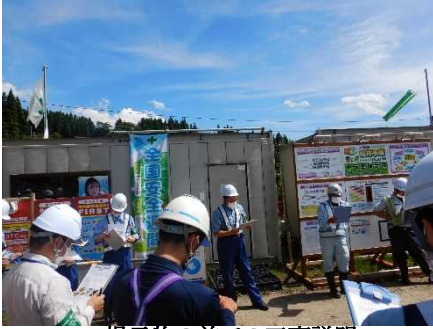
掲示物の前での工事説明 [松本建設(株) 現場]
