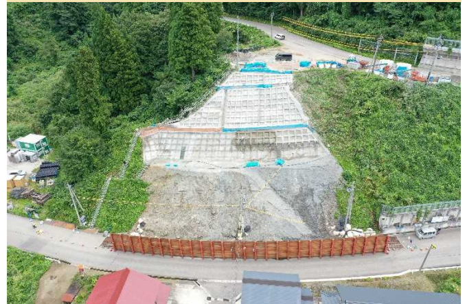
8月下旬の現地状況
