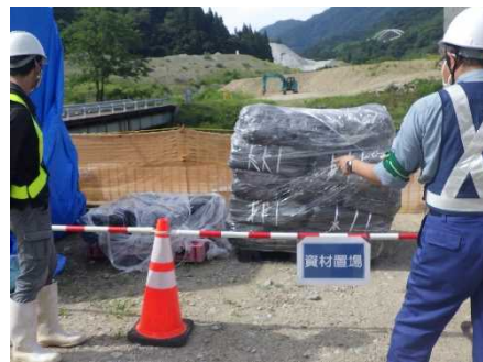
資材保管状況の確認 [(株)藤井組 現場]
