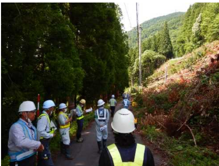
伐採作業状況の確認 [松本建設(株) 現場]
