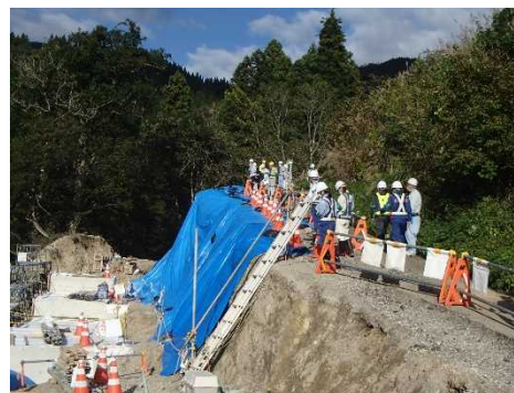
昇降設備の安全確認 [松本建設(株) 現場]
