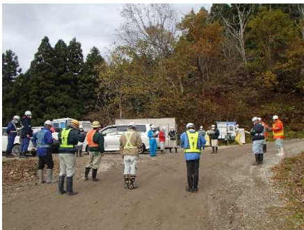
本日の作業内容の確認 [(株)岡部 現場]
