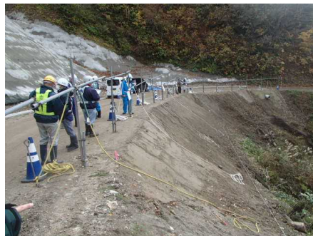
親網設置状況の確認 [(株)岡部 現場]
