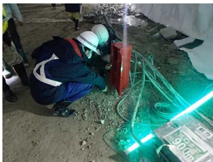
消火設備の確認 [(株)安藤・間 現場]
