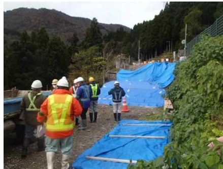
工事現場の安全確認 [中越興業(株) 現場]
