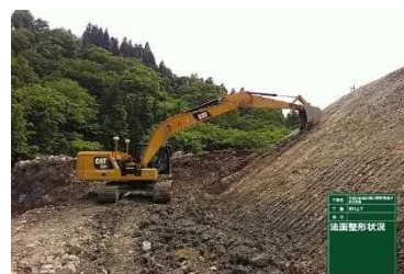
ICT建機による施工状況
