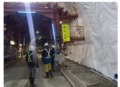
工事現場の安全確認 [(株)安藤・間 現場]
