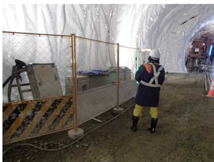
資材保管状況の確認 [(株)安藤・間 現場]
