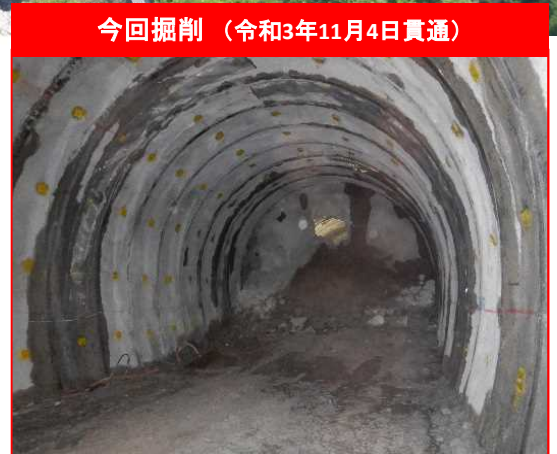
R3.11.4 貫通掘削 (株)安藤・間施工
