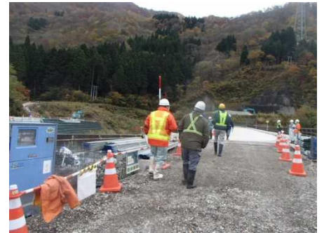
資材保管状況の確認 [中越興業(株) 現場]
