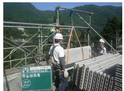
フルハーネス安全帯装着作業
