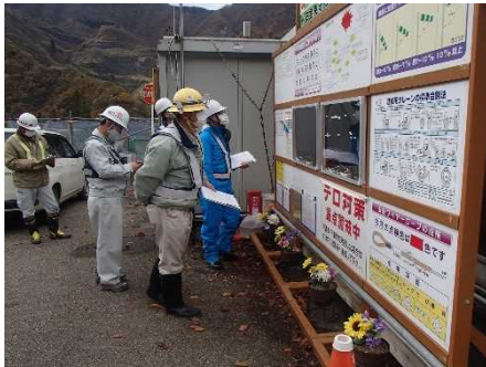
工事掲示物等の点検 [中越興業(株) 現場]
