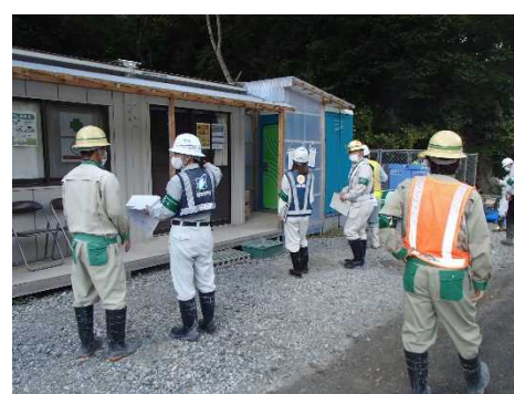
現場休憩所、消火設備等の点検 [竹沢建設(株) 現場]
