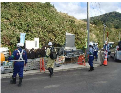
資材保管状況の確認 [松本建設(株) 現場]
