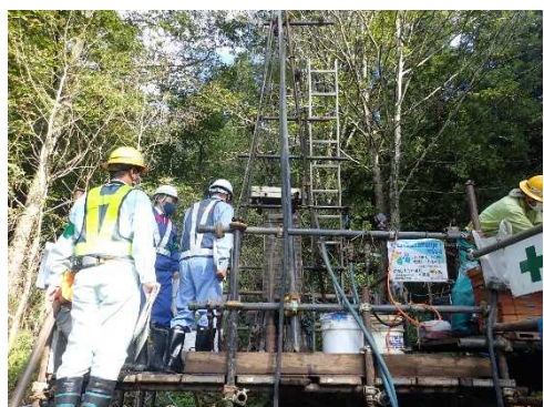
地質調査の作業現場の安全確認 [(株)ホクコク地水 現場]
