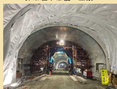
非常駐車帯覆工全景
