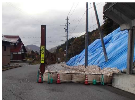
L型ガード工法の施工完了状況
