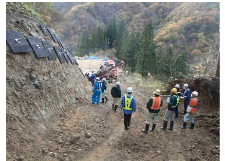
工事現場の安全確認 [(株)岡部 現場]
