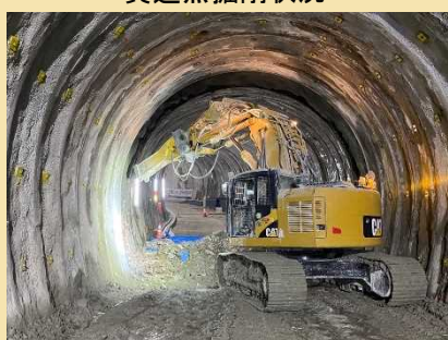
貫通点掘削状況
