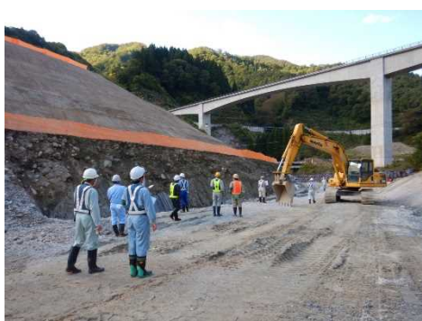
工事現場の安全確認 [(株)藤井組 現場]
