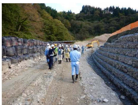
作業員の通路や落下防止対策等の確認 [(株)藤井組 現場]
