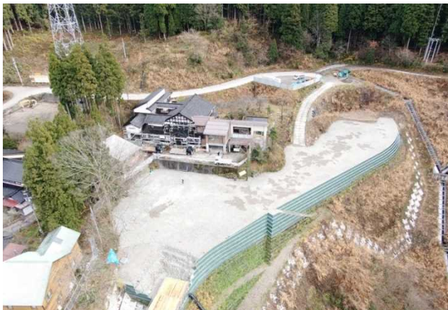
12月中旬の現地進捗状況
