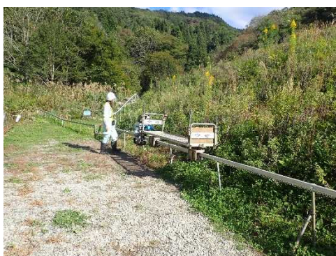
モノレール設備の安全確認 [(株)ホクコク地水 現場]
