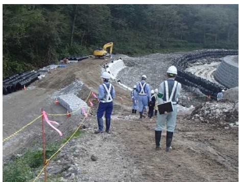
工事現場の安全確認 [竹沢建設(株) 現場]
