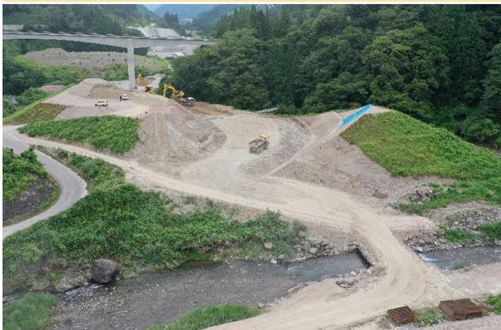
現在、仮設工事用道路を造成し渡河し対岸へ1.4m3級バックホウ、0.7m3級バックホウ(ICT)、アーテイクレートダンプを用い掘削土砂運搬を行っています。概ね800m3/日の運搬が可能です。
