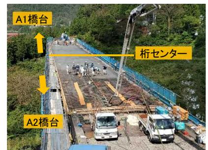
床版コンクリート打設の作業状況
