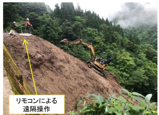
高所法面掘削の施工状況
