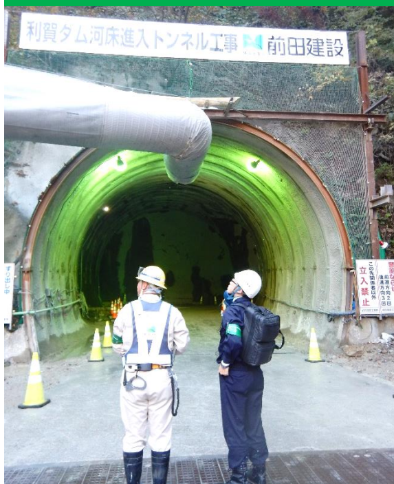
写真③:トンネル換気設備を点検する 米屋監督官(写真右)
