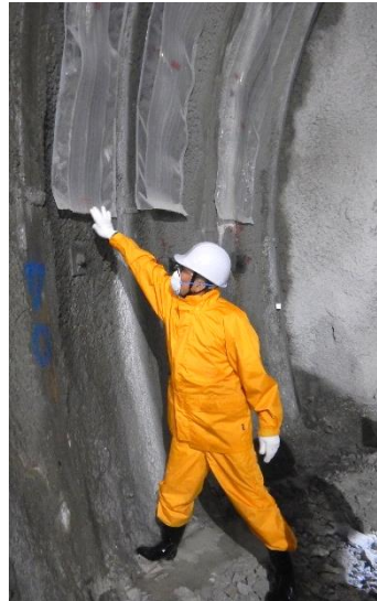
▲写真②:上部トンネルの湧水状況を確認する川村教授
