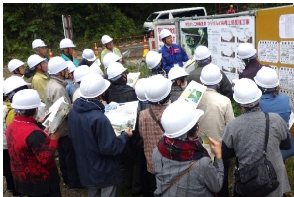
▲現場にて職員より橋梁工事の概要説明(1号車の皆様)
