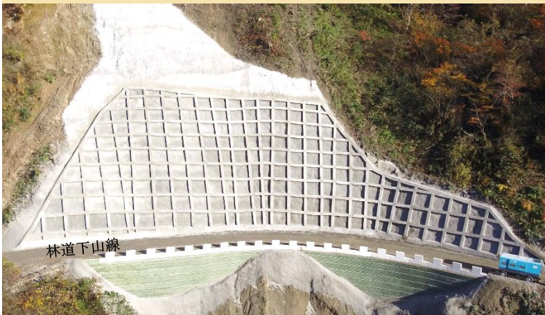
写真③：法枠工完了(11/15現在)
