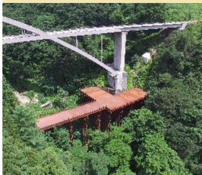
▲写真②：架設構台、受圧板撤去前
