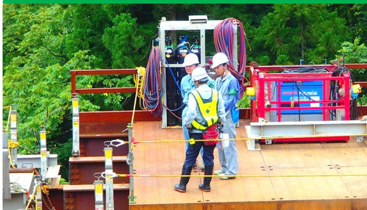
写真①:利賀大橋作業構台撤去時の安全対策点検
