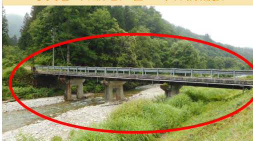
写真①：百瀬地区喜三郎谷橋補強
