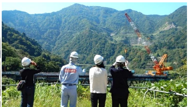
▲橋梁工事現場における環境対策などを委員に説明
