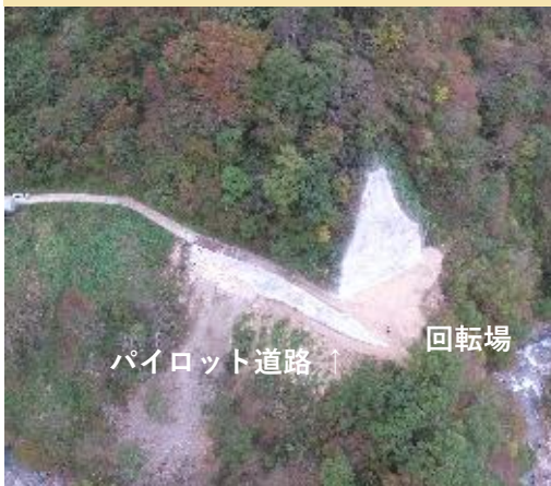
写真①：転流工パイロット道路整備状況
