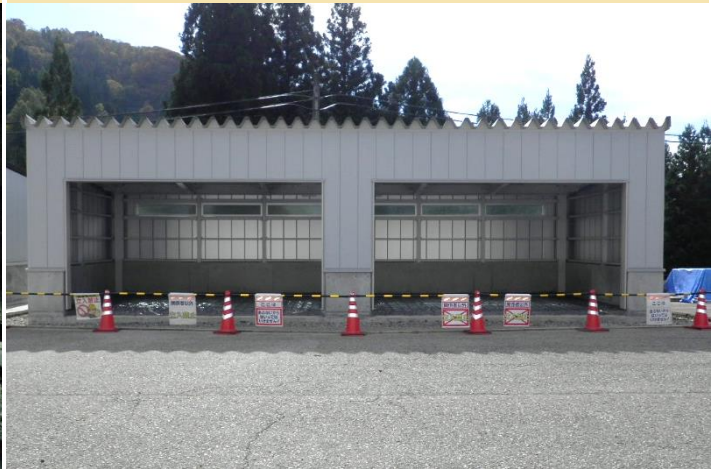
写真②: 格納用倉庫整備状況(旧利賀小学校前)
