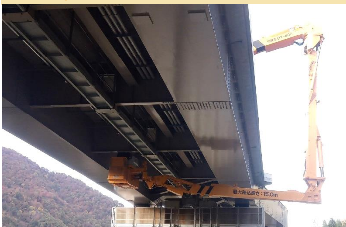
写真①:橋梁点検車(BT-400)による管路施工状況
