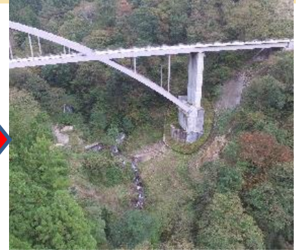
▲写真③：架設構台、受圧板撤去完了
