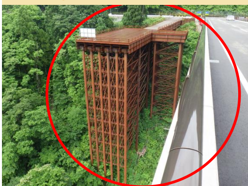
写真③：利賀大橋仮設栈橋撤去前
