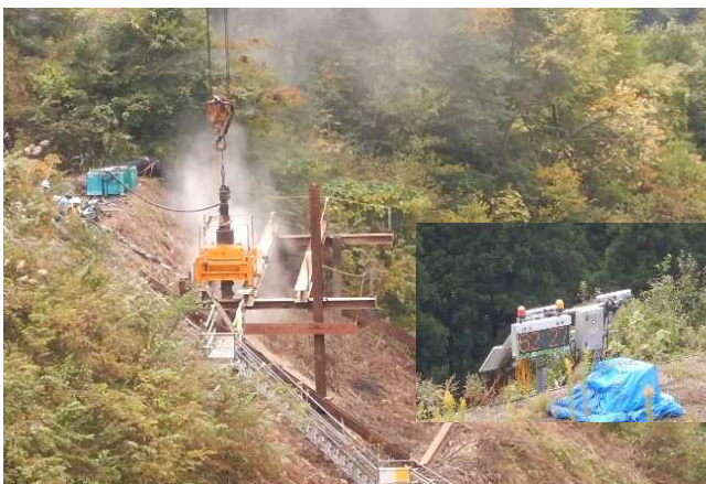
サイクルハンマー工法によるベント基礎杭打設と騒音・振動測定
