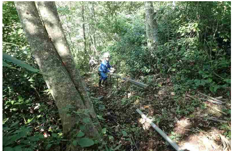
モノレール架設状況
