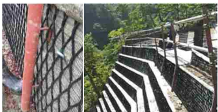
▲壁面ユニット設置金具付き 単管支柱
