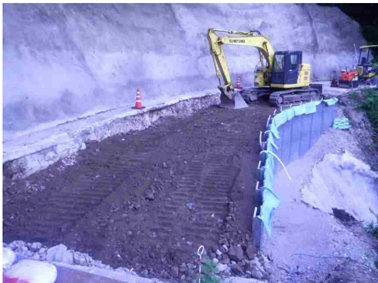
▼林道仙野原線～鋼製L型擁壁施行状況
