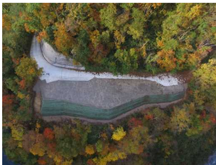
▲ヤード造成(路体盛土工1,100m 3 ・補強盛土工2,100m 3 )
