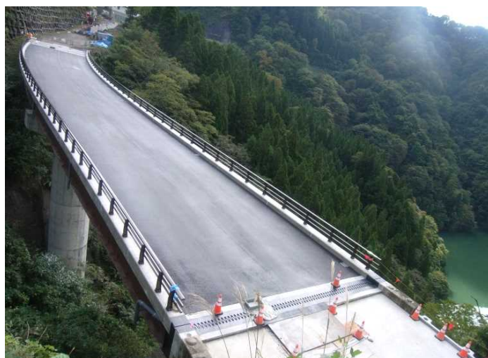
▲長崎橋完成(H29.10月撮影)
