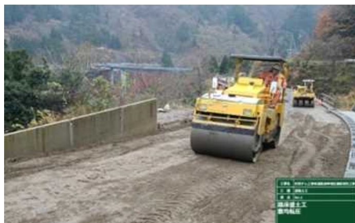
▲路床盛土転圧状況
