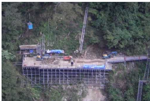
▲横抗工掘削前
