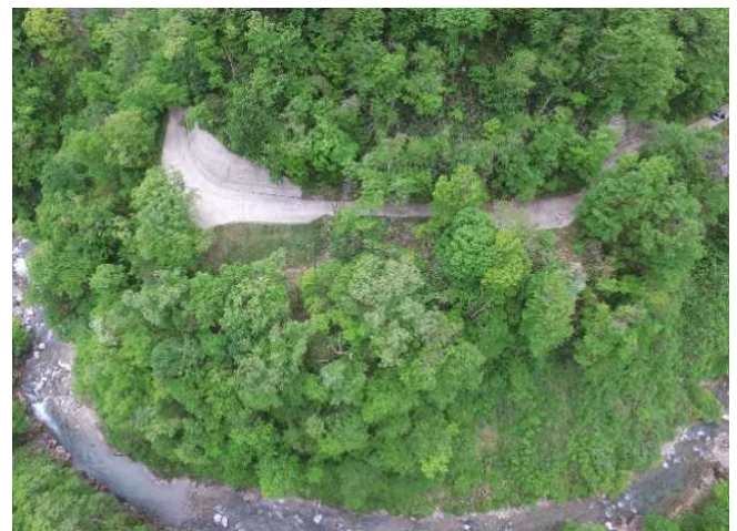
▲補強盛土施工箇所
