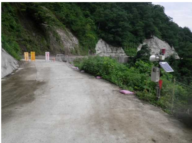
▲道路清掃、無線式警報機設置完了
