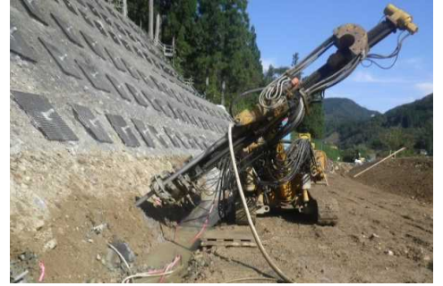
ボーリングマシン(クローラー式)による施工状況
