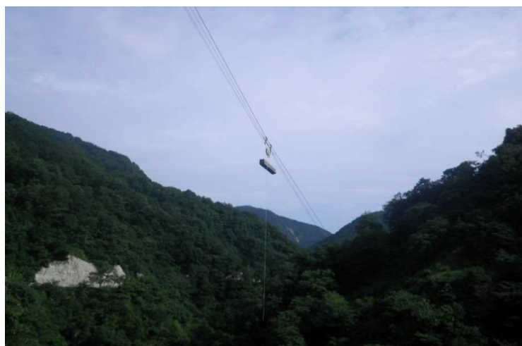
▲ダムサイト左岸-ケーブルクレーン資材運搬
