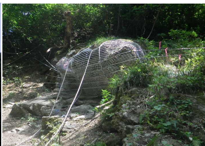
▲ダムサイト右岸-落石対策工
