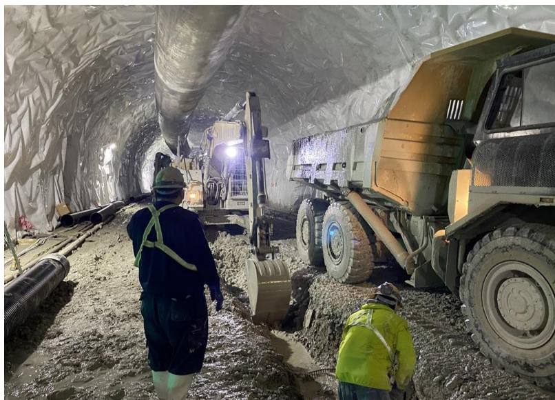
中央排水施工状況
