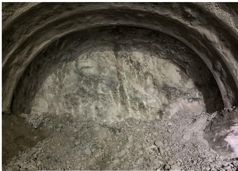
切羽地質状況
