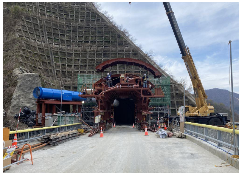
センター(型枠)組立状況
