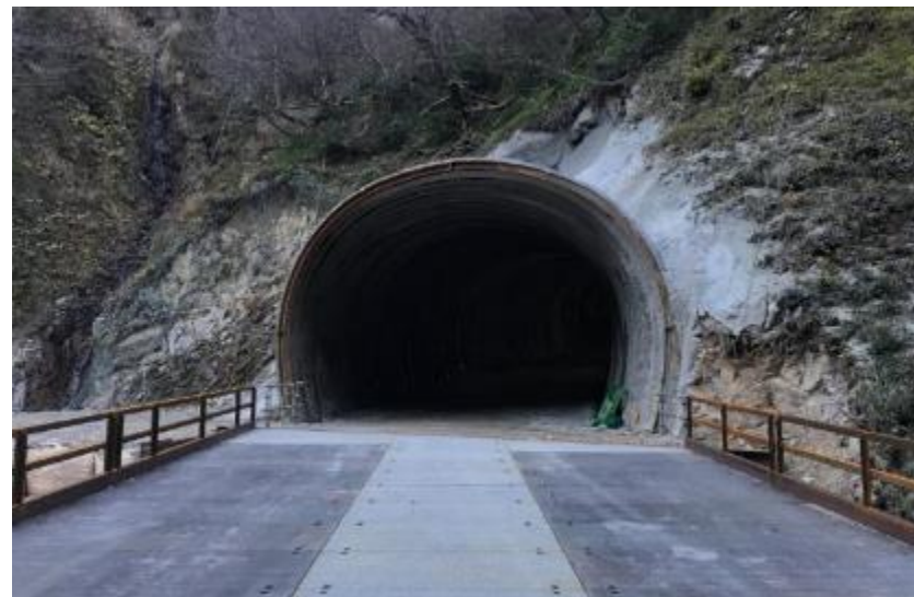
河床進入トンネル坑口部 (終点側)
