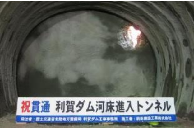
河床進入トンネル工事 令和2年8月26日10:16貫通
