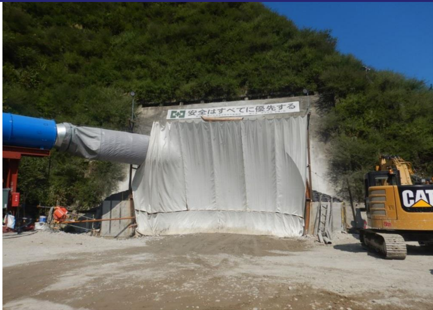
利賀トンネル坑口部（防護シート）
