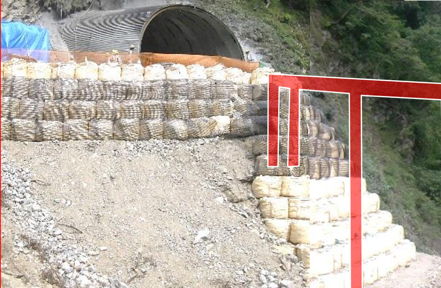
河床進入トンネル 坑口
