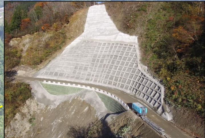
貯水池法面進入路整備工事 完成状況(令和元年11月撮影)
