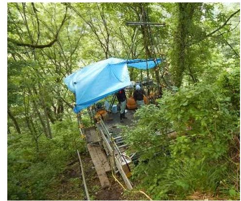
地すべり対策検討箇所でのボーリング調査状況
