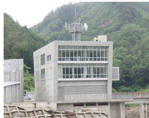
管理用事務所（他ダム事例）
