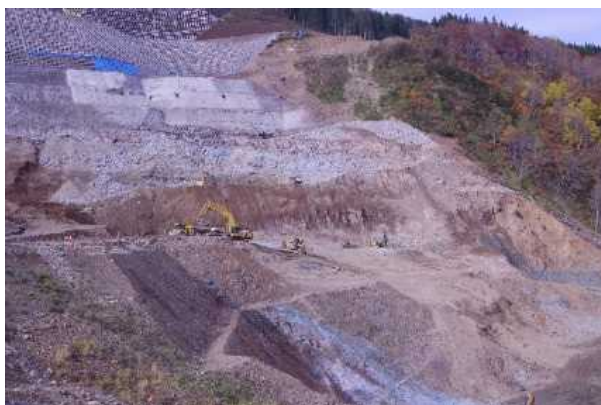
排土工の施工状況 (他ダム事例)
