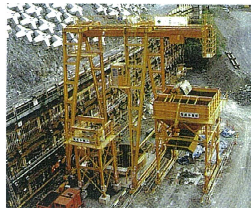
深礎杭工の施工状況 (他ダム事例)
