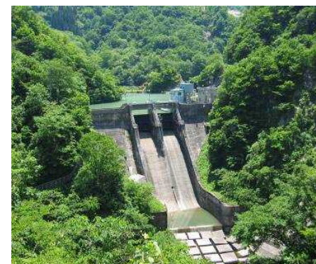
豆谷ダム（関西電力）
