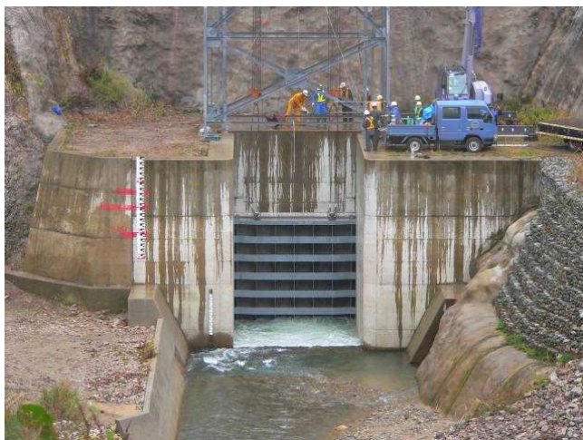
転流工閉塞状況 (他ダム事例)
