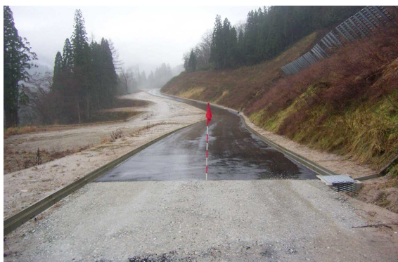
付替道路工事実施状況
