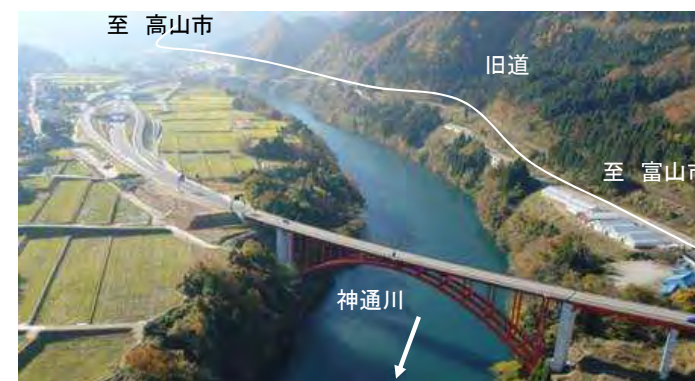
写真は既開通区間
