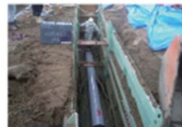
工事状況写真(排水パイプ設置) (提供 柏崎市)
