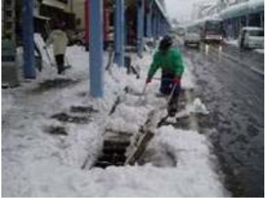
流雪溝の設置
