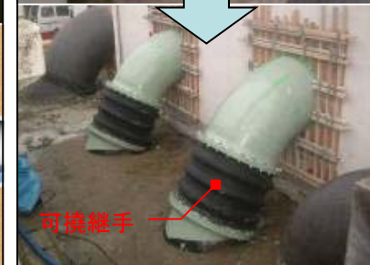
ポンプ場の耐震化(漏水防止) 〔金沢市〕
