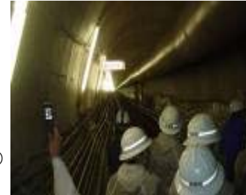
(雨水貯留管整備の事例) 〔新潟市〕
