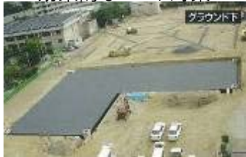
校庭雨水貯留施設整備の状況
