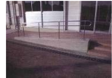
避難所玄関にスロープを整備 (富山県立山町)
