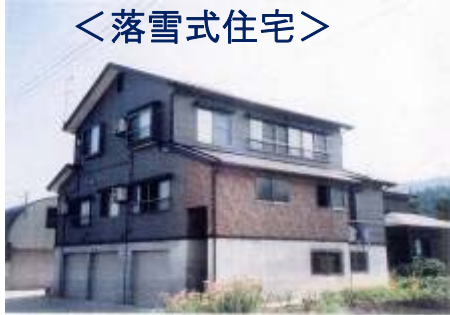
フッ素加工の屋根にあわせて高床式化した自然 落雪構造の住宅の新築に対する助成 (新潟県十日町市・南魚沼市)
