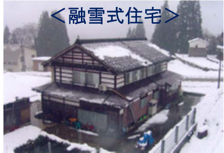
既存住宅への屋根融雪装置の設置 に対する助成(南砺市)
