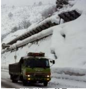
雪崩予防柵の設置
