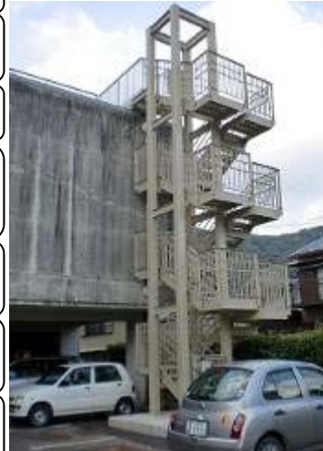
避難ビルとして活用できるよう、既存建築物に外階段を設置(太平洋側の事例)
