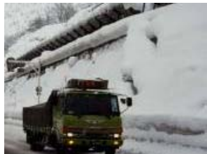
雪崩予防柵の設置
