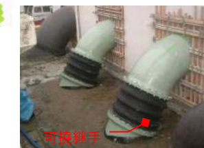
ポンプ場耐震化
