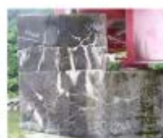
下部工にASRIによる劣化が疑われる
