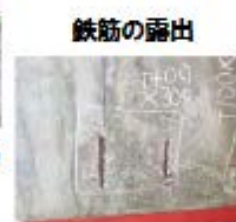
下部工にASRIによる劣化が疑われる
