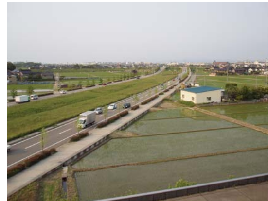
【金沢外環状道路(海側幹線)】(石川県)
