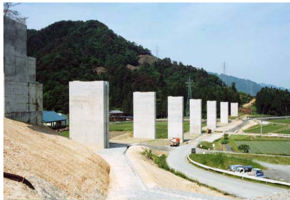
【中部縦貫自動車道国道158号永平寺大野道路】 (福井県)
