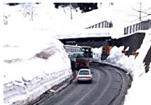
【国道17号神立芝原地区堆雪帯確保】 (新潟県)
