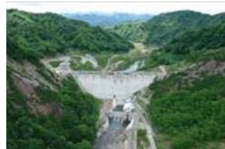
図 8 横川ダムの完成(山形県)
