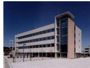
図 12 グリーン庁舎「七尾西湊合同庁舎 1 号館」(石川県)
