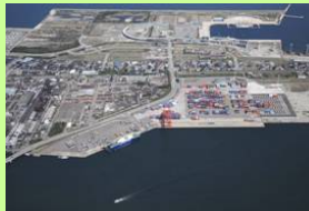
富山新港多目的国際ターミナル 【出典】富山県HP
