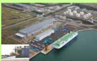
金沢港多目的国際ターミナル 【出典】金沢港湾・空港事務所
