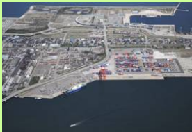
富山新港多目的国際ターミナル 【出典】富山県HP
