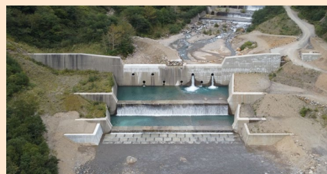
今年度完成した湯川第13号砂防堰堤
