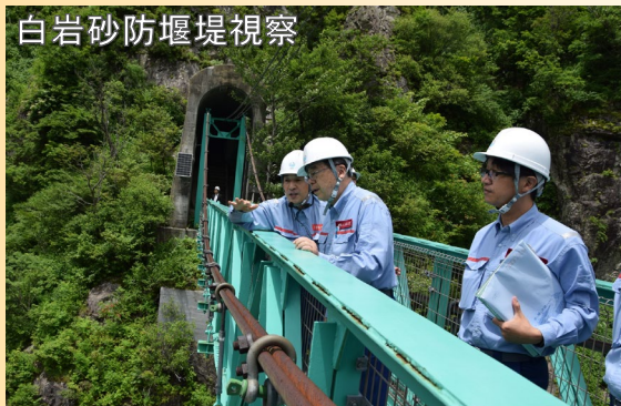
国重要文化財に指定された歴史的砂防施設：白岩砂防堰堤を視察する斉藤大臣
