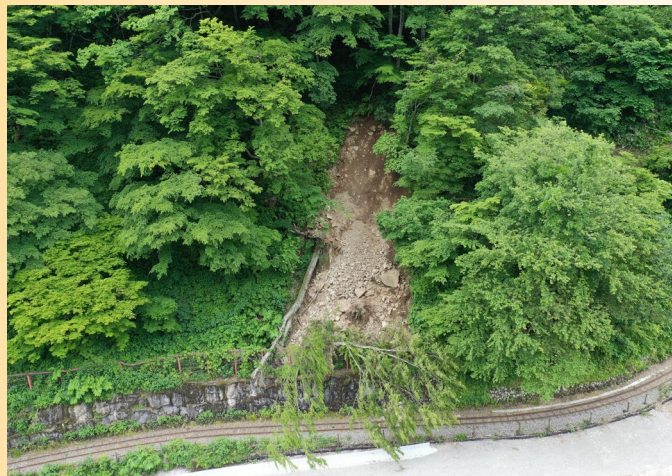
斜面崩壊箇所をUAVにて望む
