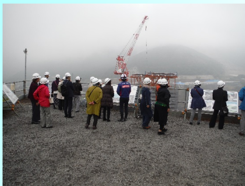
無人化施工や24時間体制で復旧工事を実施
