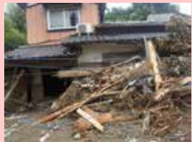
流木、家屋の被災状況(黒川)
