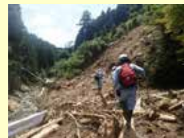
土砂災害危険箇所調査状況(黒川)
