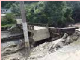
道路の被災状況(疣目川)
