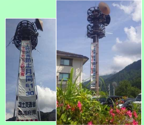
立山砂防事務所構内
