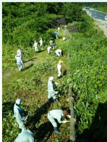
除草の作業状況
