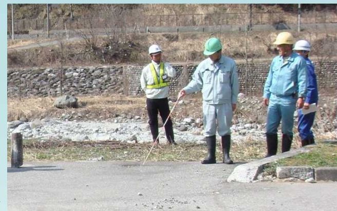
車止め損傷箇所に車両進入防止措置を追加 (立山1号公園)
