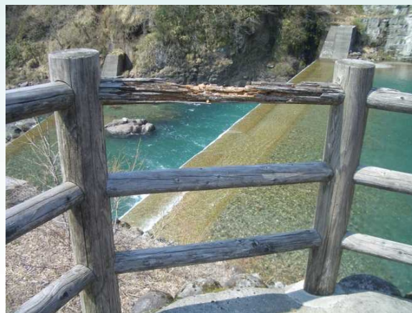
木製転落防止柵が損傷しており補修(常願寺川水辺の楽校)
